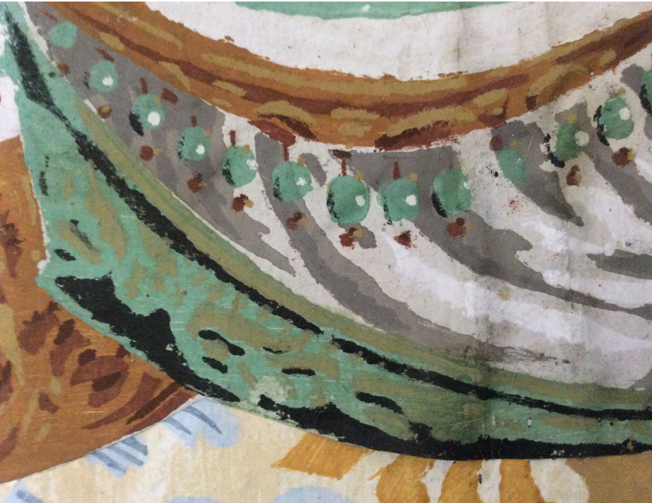
Figur 15 (3.4.15): Förtillverkad volangbård som klippts till och anpassats på plats för att stämma med rummets format. Världsarvsgården Gästgivars. Foto: Ingalill Nyström
